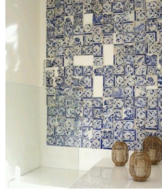
(لوحة 47) استخدام غير تقليدي في تنسيق البلاطات الخزفية حيث لعب المصمم بتنوع اتجاهات رص البلاطات
